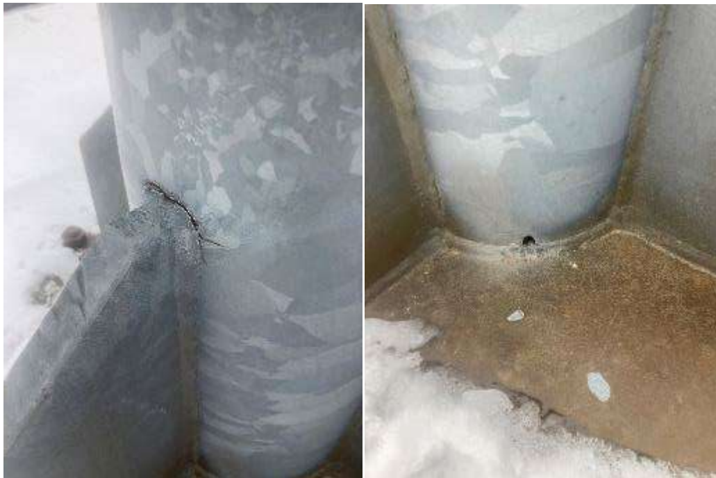
Photo 5 – Désordres structurels observés sur le pylône actuel.
